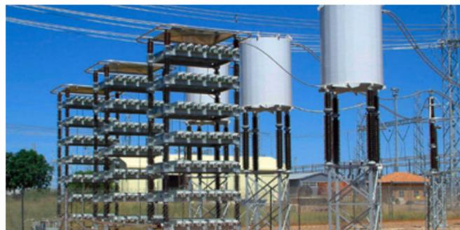
Drosselspulen gefertigt von Trench Austria in Leonding. Bild: Siemens
